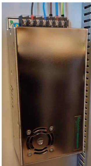
Slika 6.2: Prikaz napajanja ABL1RPM24100
