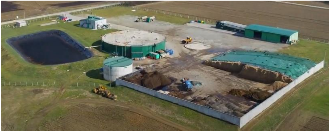
Slika 2.1: Kompleks bioelektrane Bioel [2]
