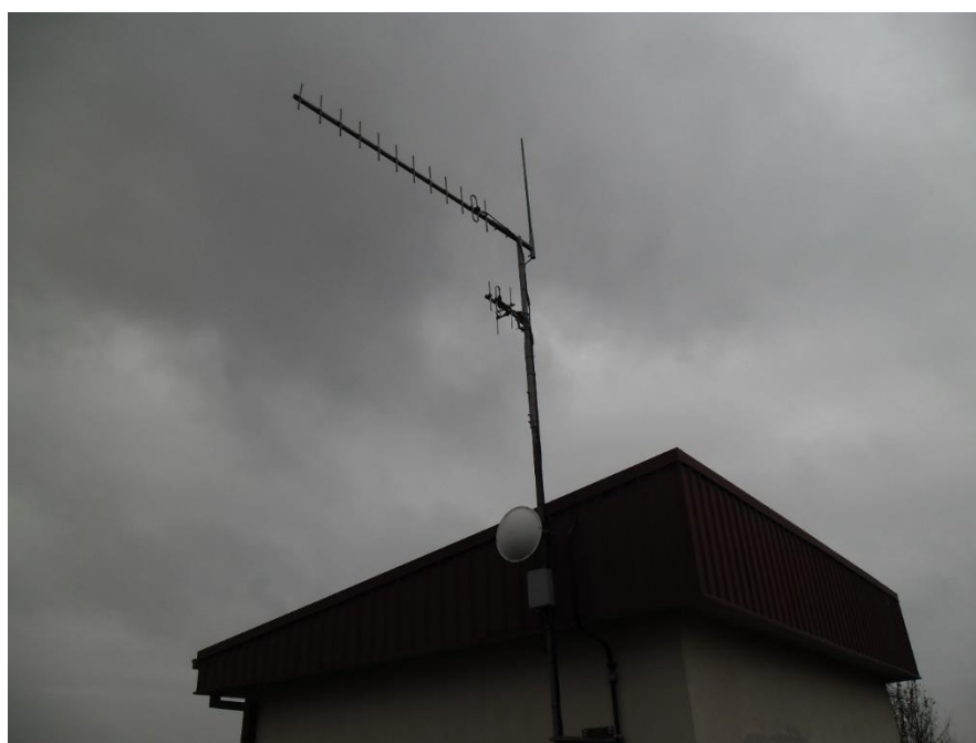
Slika 3.13: Rezervni sustav komunikacije sa dispečerskim centrom (RiPEX)
