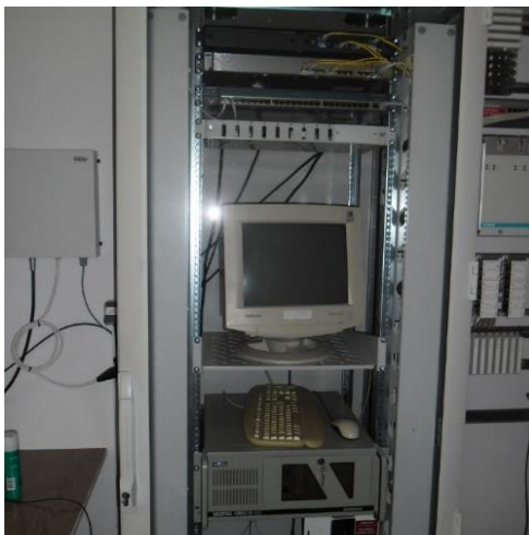
Slika 3.14: Stanično računalo i koncentrator podataka
