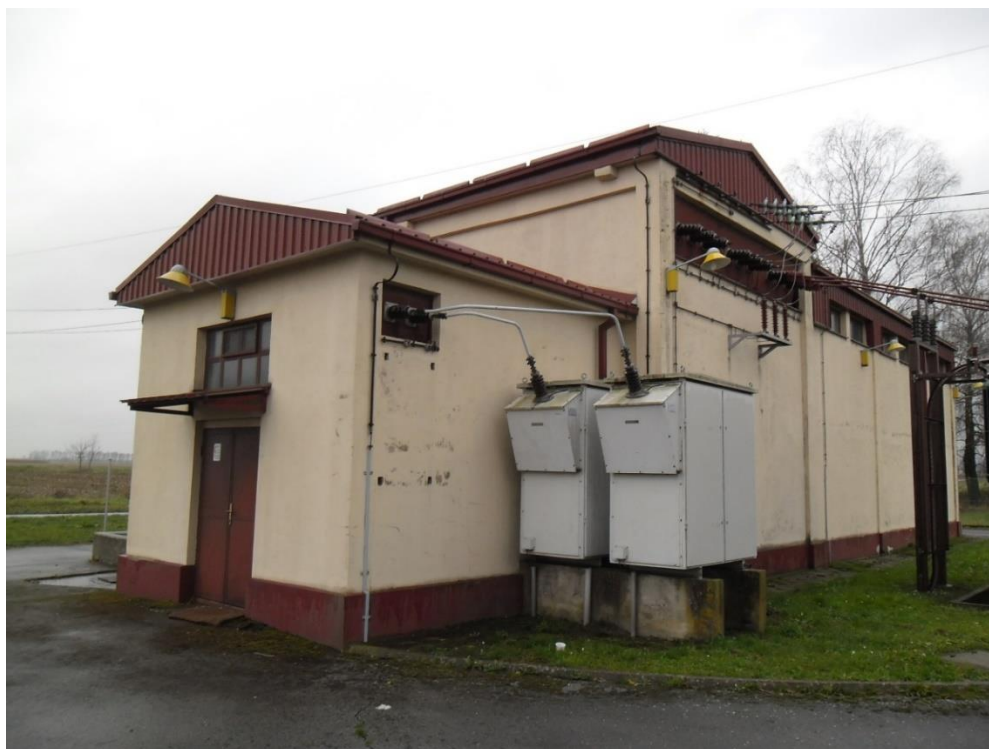
Slika 3.8: Trafostanica 35/10(20) kV Đurđevac
