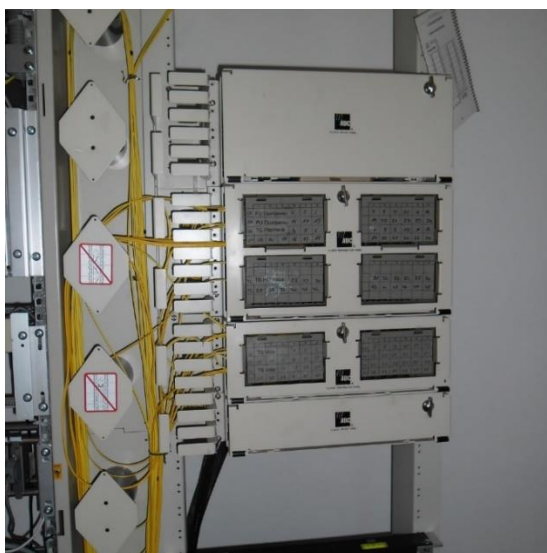
Slika 3.15: Optički razdjelnik
