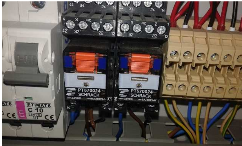
Slika 2.7: Mini releji Schrack PT570024
