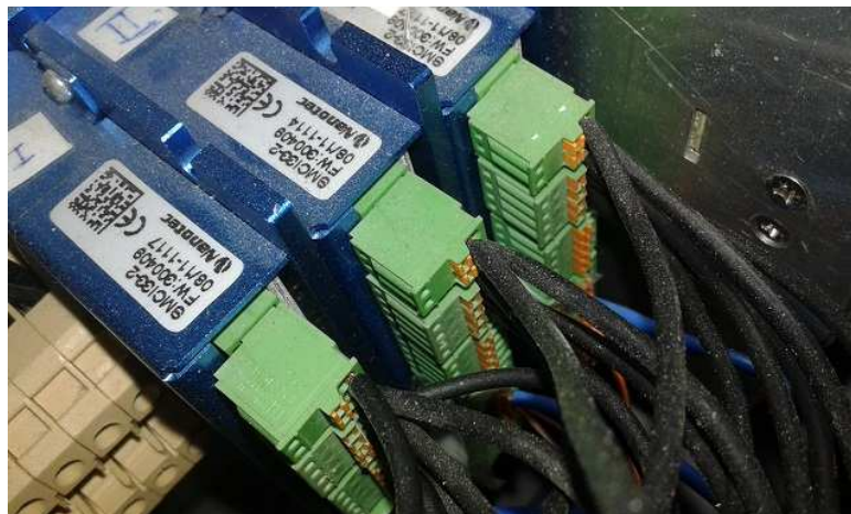
Slika 2.6: Driveri za koračne motore Nanotec SMC 133-2
