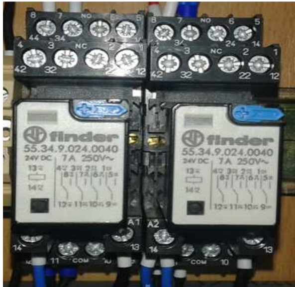
Slika 2.11: Dva releja za upravljanje smjera pokretne trake
