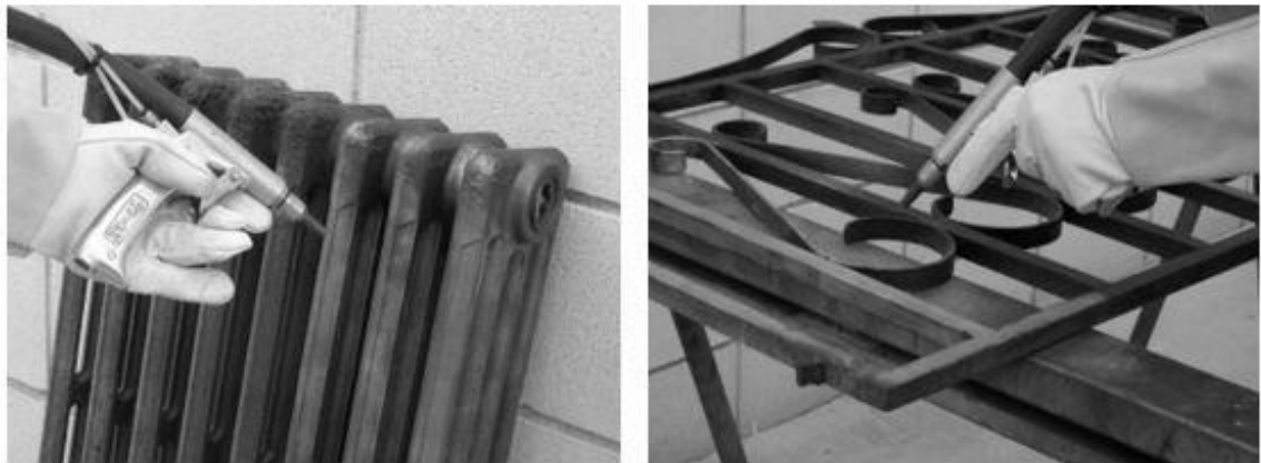
Slika 8.10: Pjeskarenje metalnih dijelova radijatora i ograde [68]
