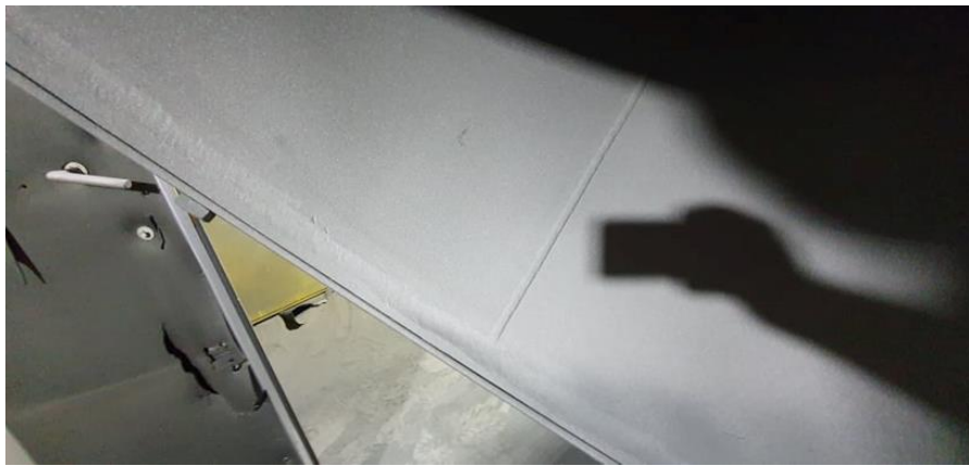
Slika 6.10: Izgled površine nakon pjeskarenja
