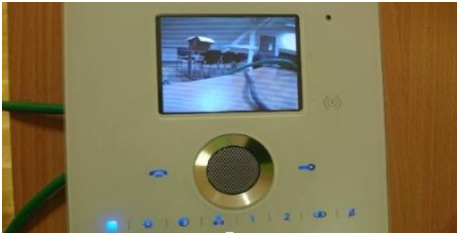
Slika 3.24. Pogled sa CCTV kamera
