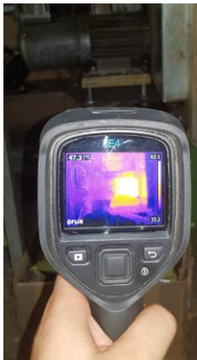
Slika 10.1: Prikaz elektromotora snimljenog termografijom
