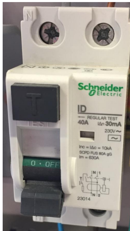
Slika 3.1 FID sklopka
