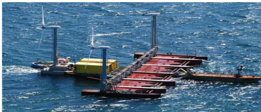
Slika 12. Vjetroelektrana „Posejdon“ u Danskoj. [7]
