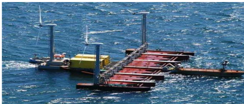
Slika 12. Vjetroelektrana „Posejdon“ u Danskoj. [7]
