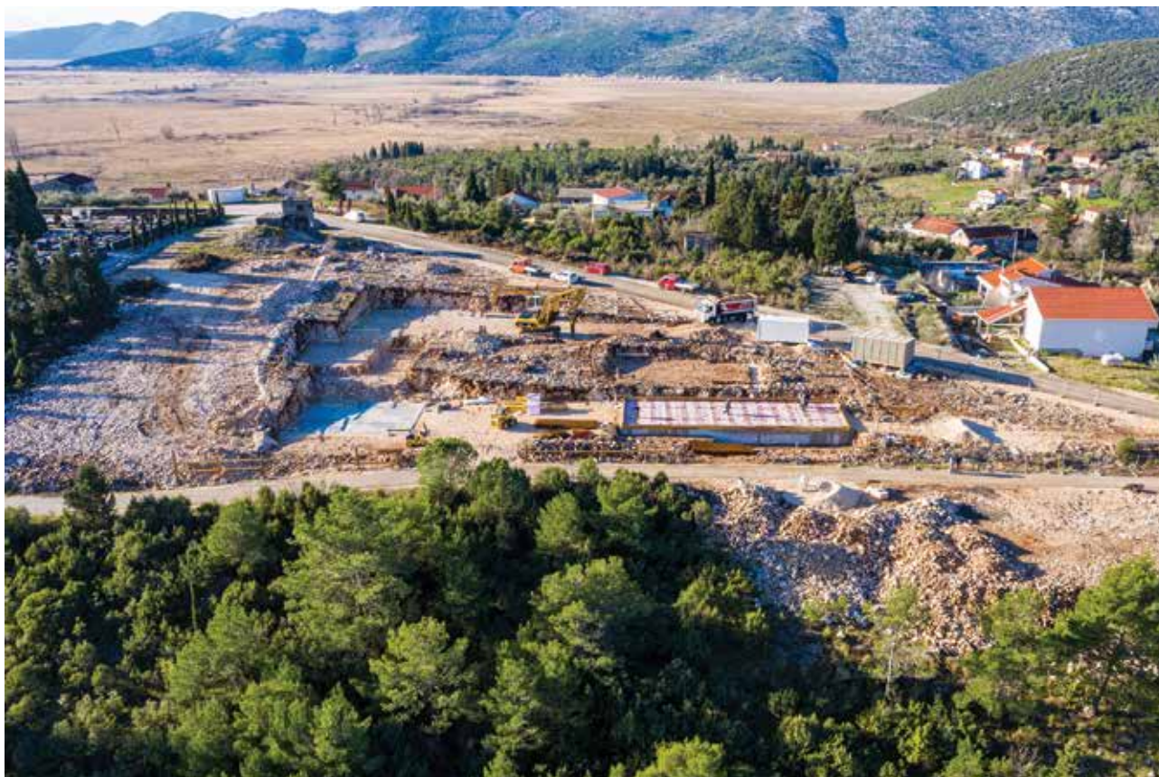
Slika 10. Zračni snimak gradilišta nove zgrade, Lapidarij/2020. foto: Mihael Talajić
