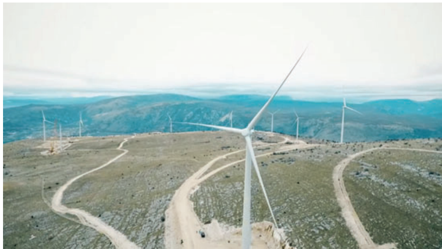
Slika 3. Vjetroelektrana Podveležje kod Mostara
