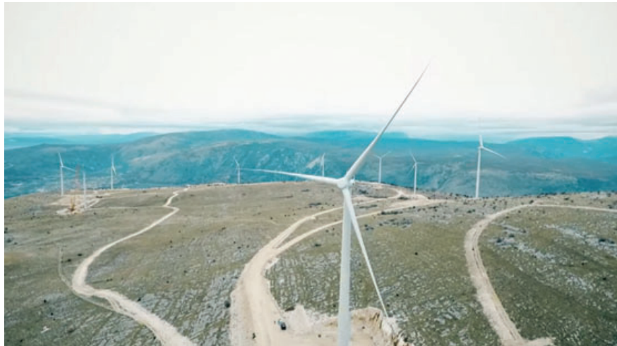
Slika 3. Vjetroelektrana Podveležje kod Mostara
