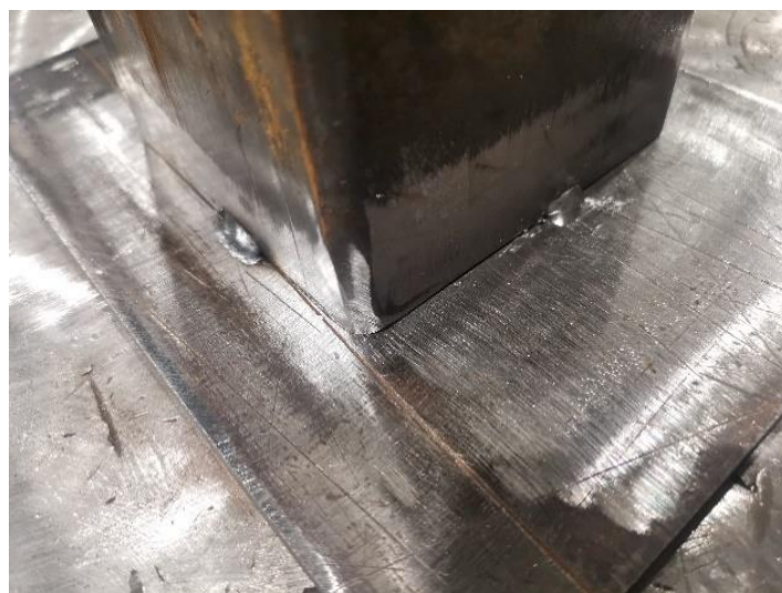
Slika 6.13: Postavljanje zavara pripajanja
