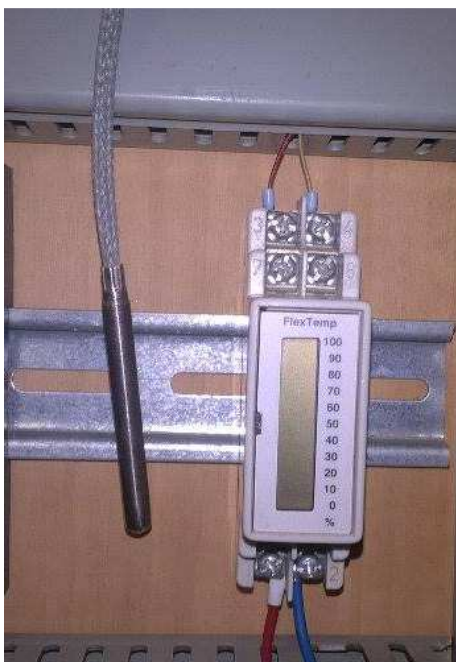
Slika 3.8: Pretvarač otpora i PT100 temperaturna sonda
