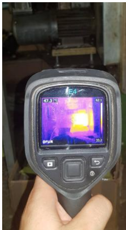
Slika 10.1: Prikaz elektromotora snimljenog termografijom
