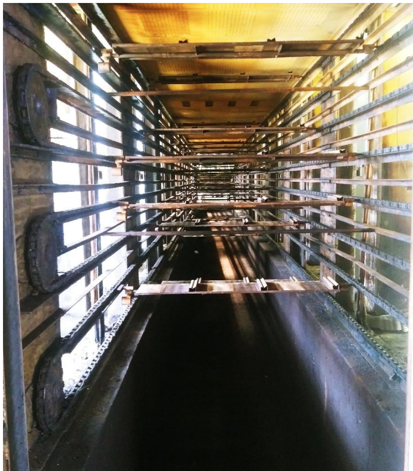
Slika 8.12: Sušara s postavljenim rešetkama
