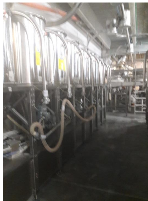
Slika 7.7. Silosi za aditive
