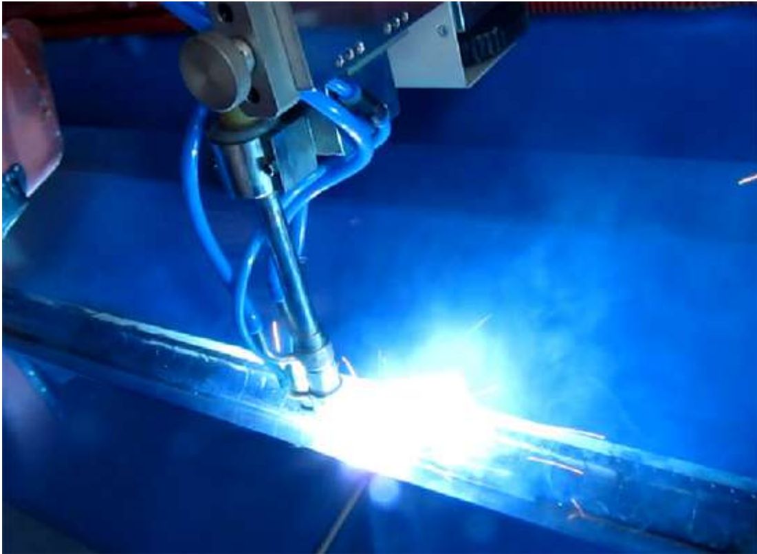
Slika 6.7. Zavarivanje MAG postupkom [14]
