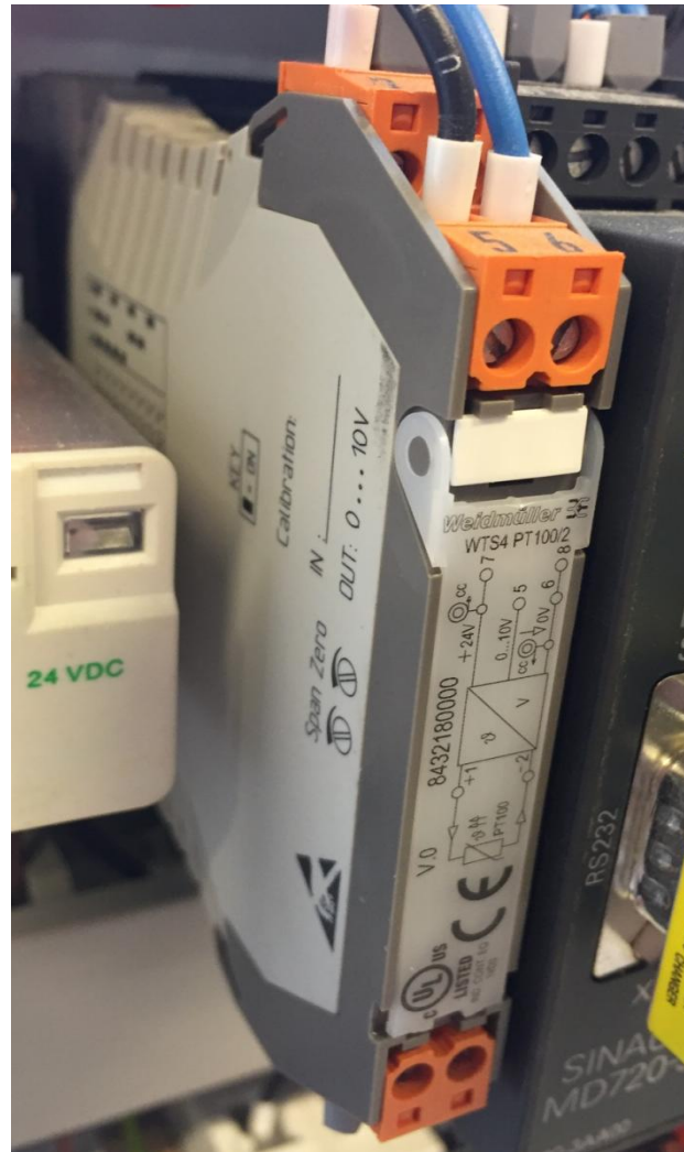
Slika 3.11 Modul za temperaturnu sondu
