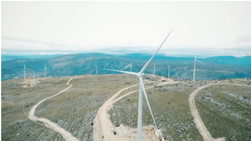
Slika 3. Vjetroelektrana Podveležje kod Mostara
