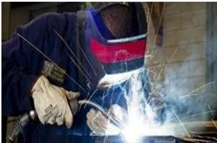
Slika 3. Zavarivanje čelične konstrukcije
