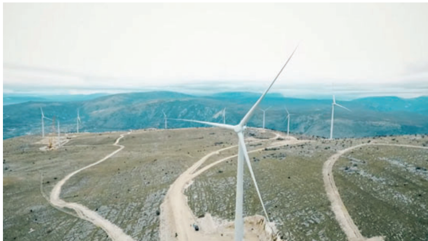
Slika 3. Vjetroelektrana Podveležje kod Mostara
