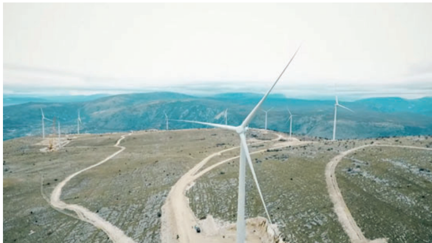
Slika 3. Vjetroelektrana Podveležje kod Mostara
