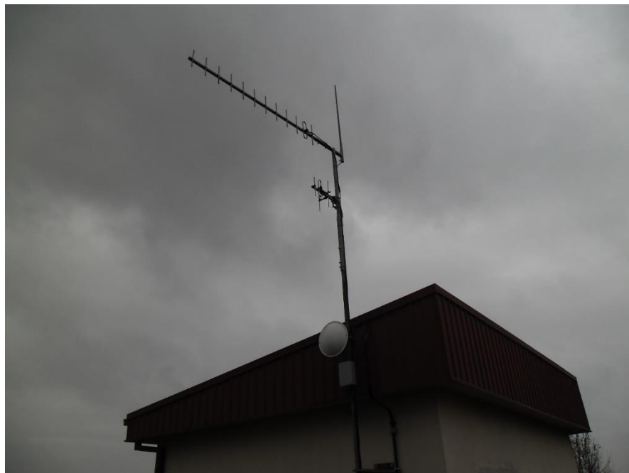
Slika 3.13: Rezervni sustav komunikacije sa dispečerskim centrom (RiPEX)
