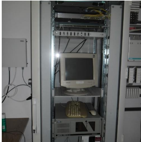
Slika 3.14: Stanično računalo i koncentrator podataka
