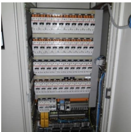
Slika 3.16: Razvod DC sustava upravljanja
