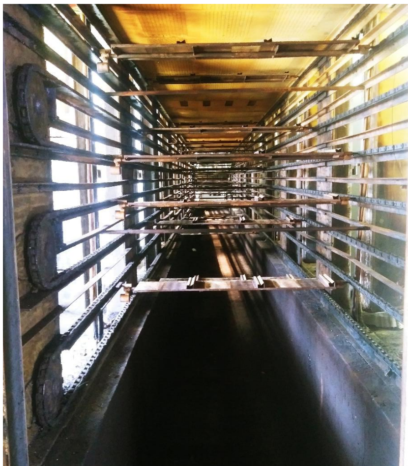
Slika 8.12: Sušara s postavljenim rešetkama
