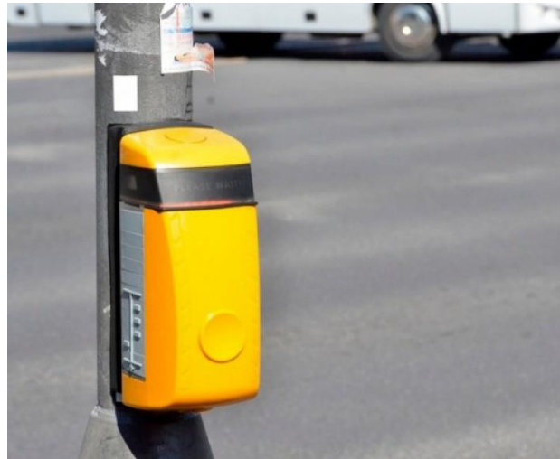
Slika 1.14. Zvučna signalizacija na semaforu
