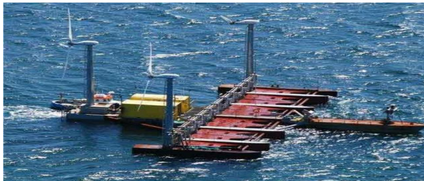
Slika 12. Vjetroelektrana „Posejdon“ u Danskoj. [7]
