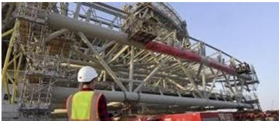
Slika 4. Rad s teškim strojevima prilikom montaže čelične konstrukcije
