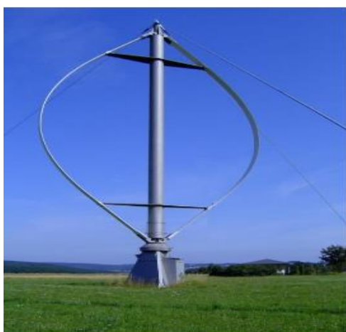
Slika 6. Darrieusova turbina [6]
