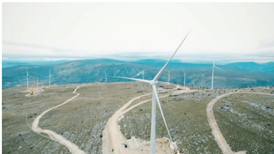
Slika 3. Vjetroelektrana Podveležje kod Mostara
